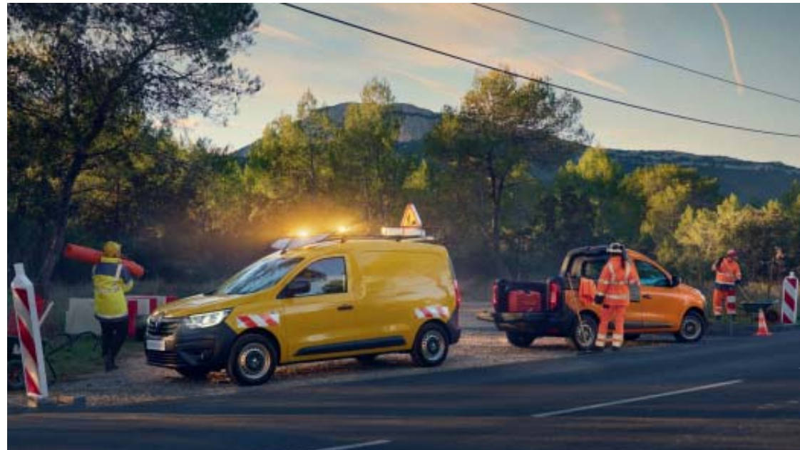
Express Van chantier et pick-up
